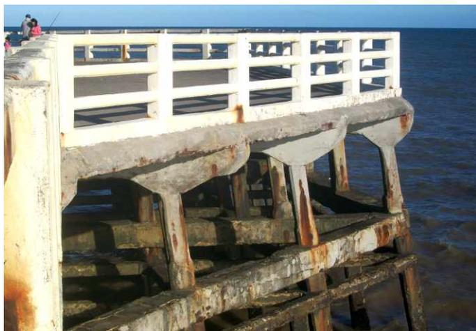
Fig 2: Muelle de hormigón armado que está sufriendo los efectos corrosivos del agua de mar.
