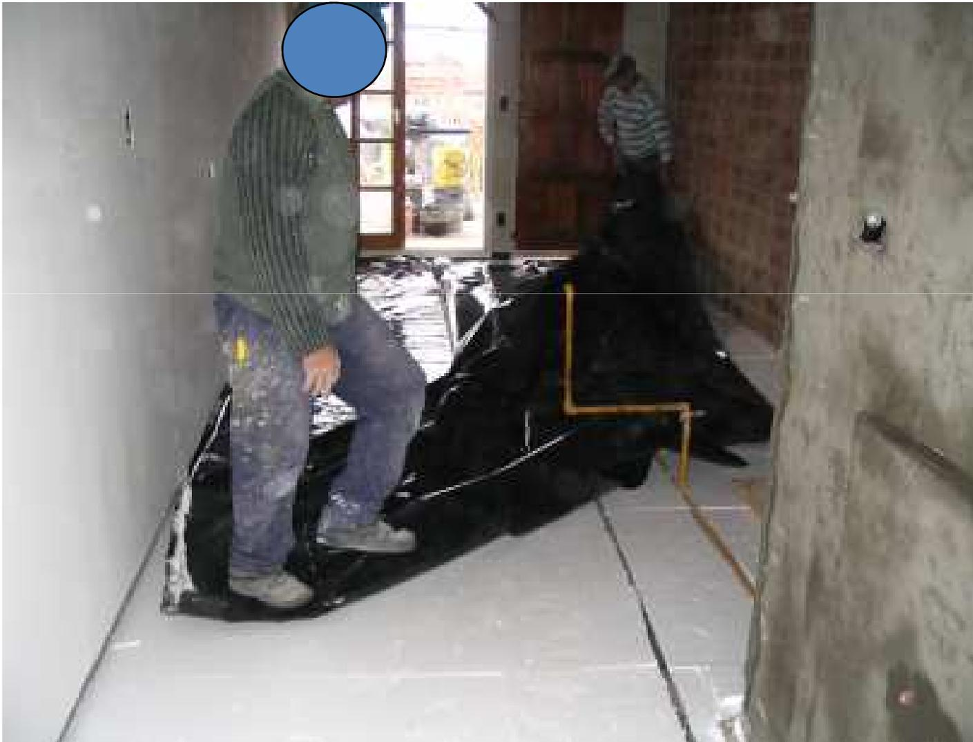
Colocación de 40 mm EPS sobre machihembrado pino y tendido de barrera de vapor de polietileno 200 micr.
